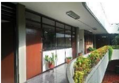
Fotografía N°24. Exterior del archivo.
