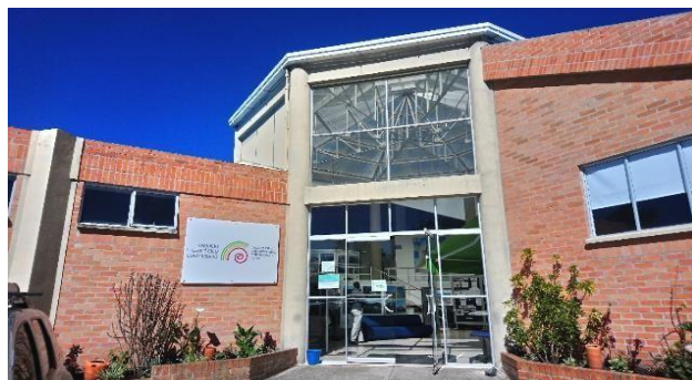
Fotografía N°47. Fachada sede Pasto.
