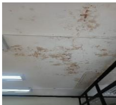
Fotografías N°25 y 26. Manchas de humedad en muros y techo.
