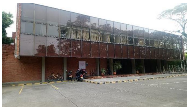
Fotografía N°23. Fachada sede Cali.
