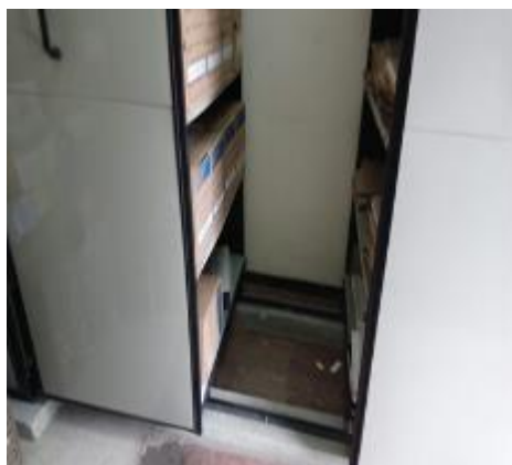
Fotografía N°6. Suciedad en el suelo. Nómina.
