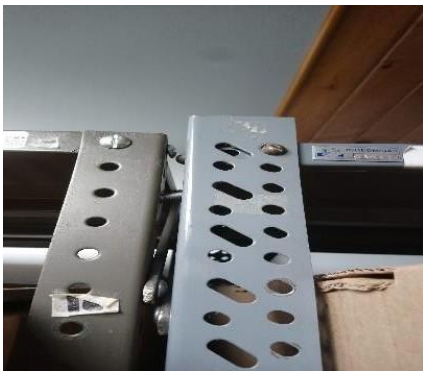
Fotografía N°56. Sistema de anclaje entre estantes con tornillos.
