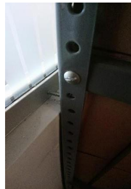
Fotografía N°57. Tornillo de anclaje al muro
