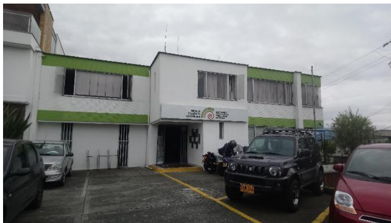
Fotografía N°64. Fachada sede Manizales.
