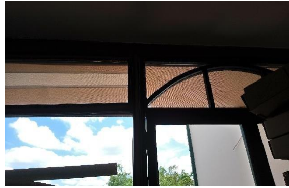
Fotografía N°84. Anjeo en las ventanas.
