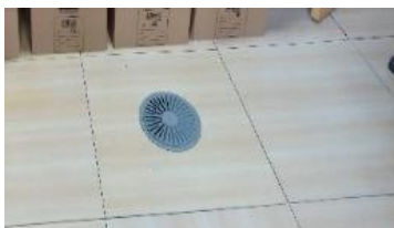
Fotografía N°14. Rejilla de ventilación en el piso
