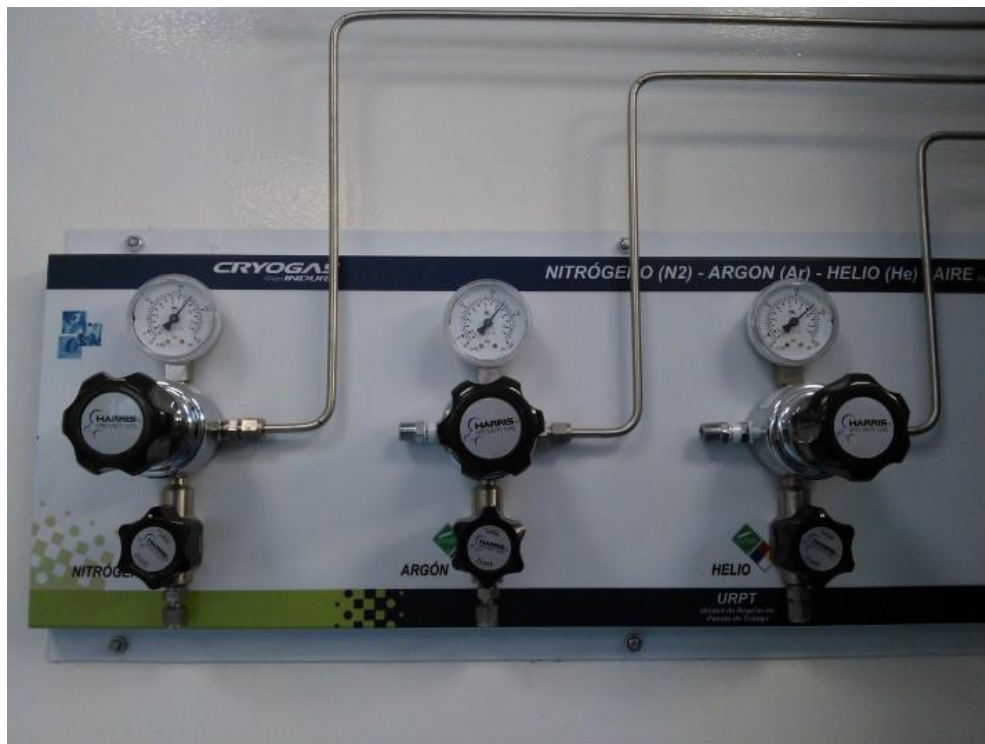
Ilustración 5. Modelo de tablero URPT para tres gases
