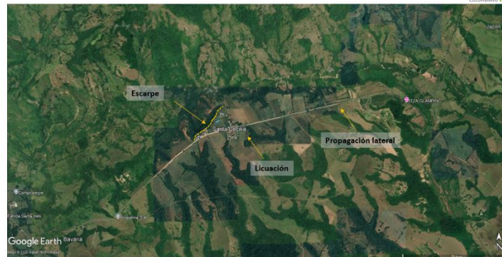
Afectaciones registradas en el centro poblado Santa Cecilia
