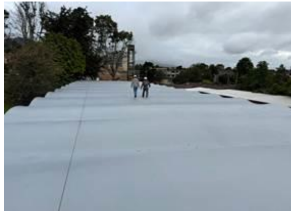
Mantenimiento Cubiertas Sede Can
