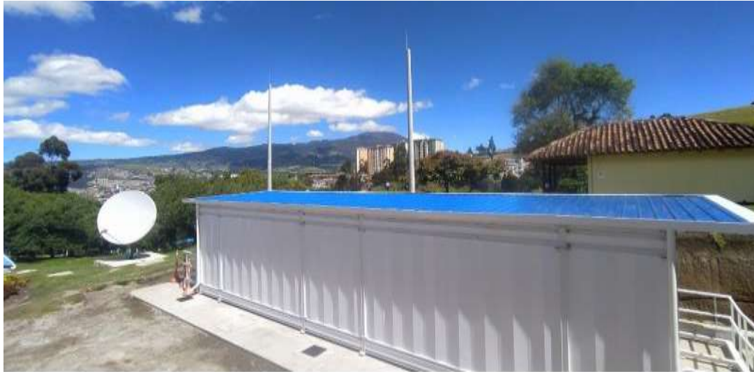
Ilustración 22. Data Center en Contenedor Sede Pasto. Centro Alterno de Monitoreo RSNC. Vista exterior e interior.
