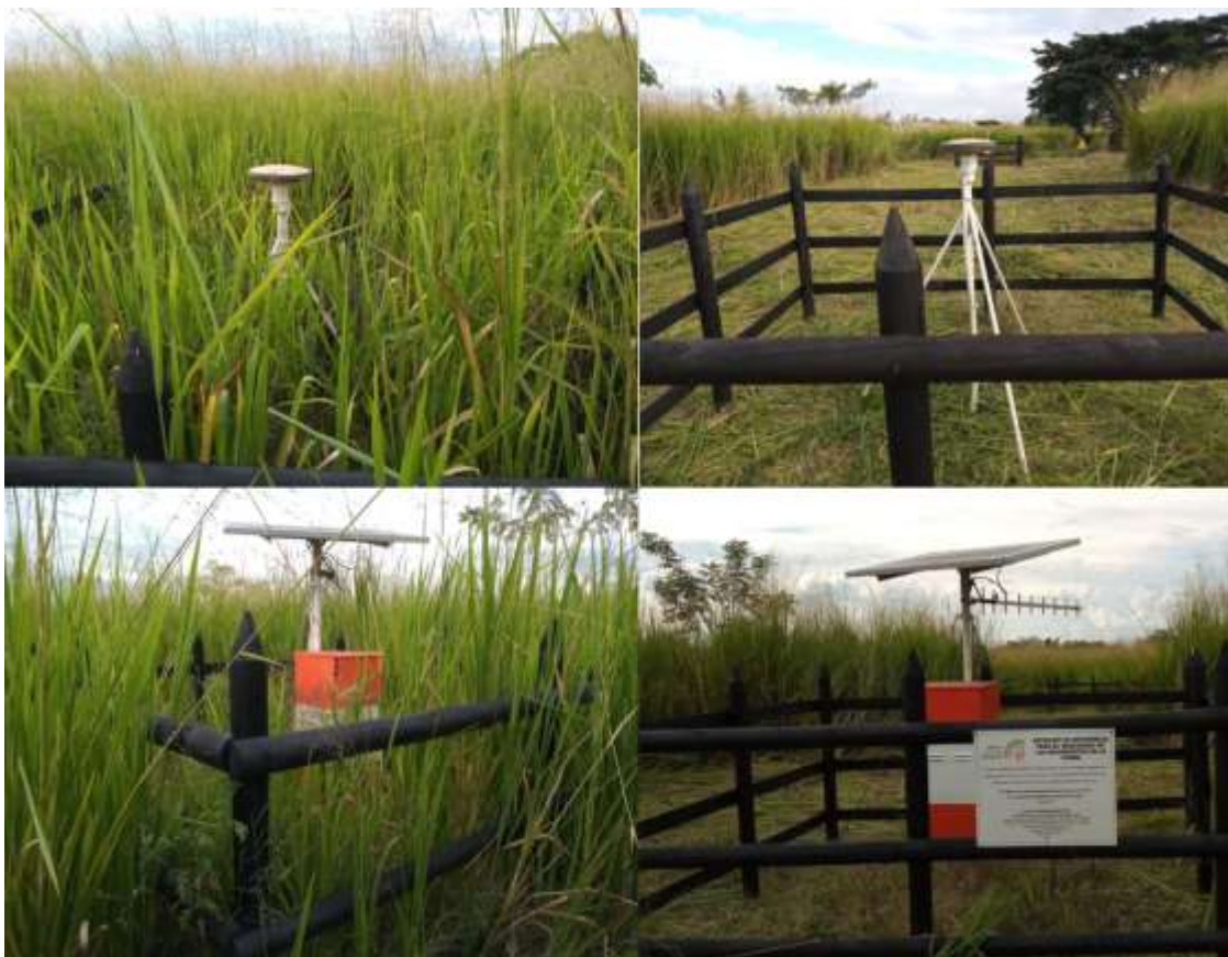
Figura 121. Estado de la antena y el gabinete antes (Izq) y después del mantenimiento (der) en estación GNSS en Candelaria, Valle
