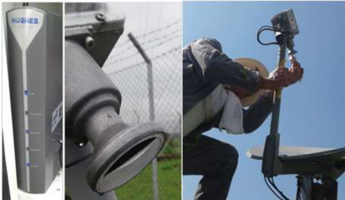
Figura 118. Mantenimiento de sistema de transmisión de datos via internet satelital
