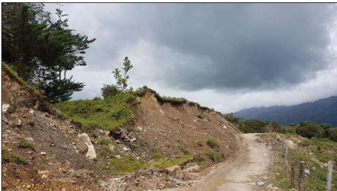
Figura 96. Vista carretera veredal, parte baja estación SEM4
