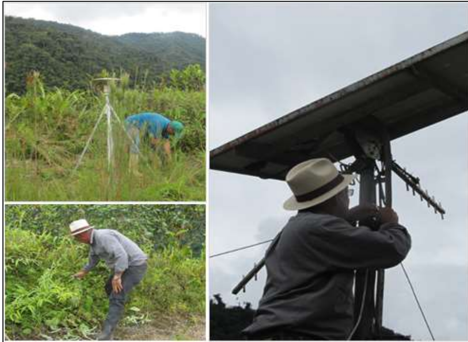
Figura 117. Condiciones previas a la ejecución de mantenimiento en estación GNSS
