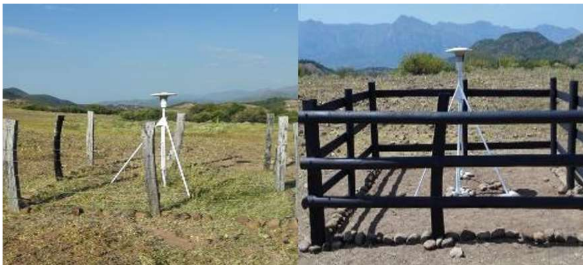
Figura 119. Mantenimiento de cerramiento de la estación instalada en el desierto La Tatacoa, antes (izq), y después (der).
