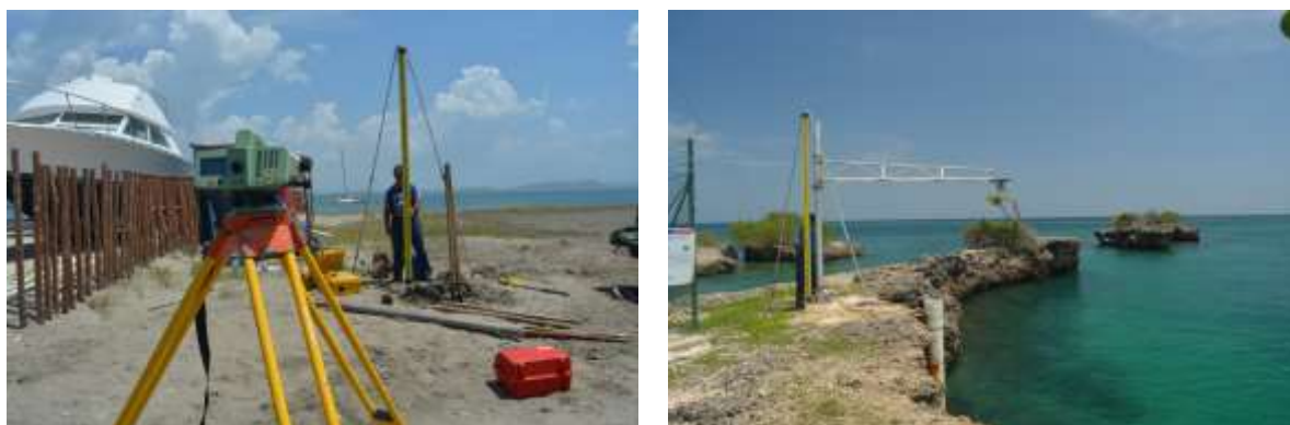
Figura 101. Nivelación geodésica de conexión geodésica de mareógrafo. Mira localizada sobre la referencia geodésica (izq) y referencia del mareógrafo (der).
