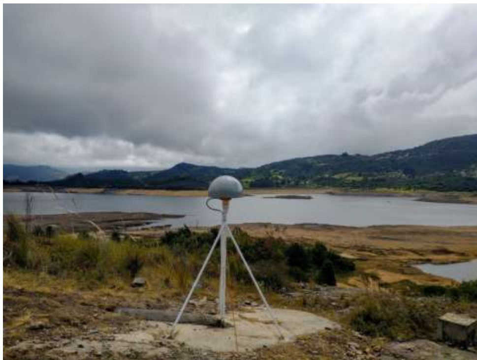
Figura 127. Estación permanente instalada en la represa San Rafael de la EAAB
