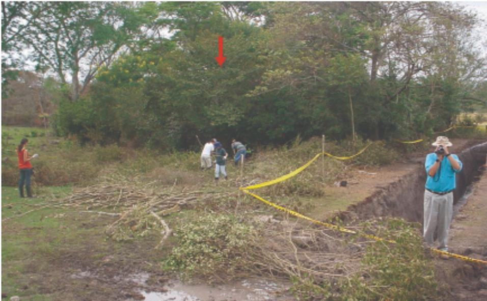
**Figura 37.** Trabajo de adecuación de troncos y palos generados en el descapote para cubrir el piso de la trinchera. Si se tiene guadua, es más fácil de colocar y permite un cómodo desplazamiento dentro de la trinchera.
