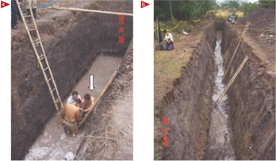
**Figura 36. a.** Acumulación de aguas lluvias en la parte más profunda. Note la pendiente que favorece el flujo de agua hacia el fondo de la trinchera. **b.** Extracción del agua con motobomba.
