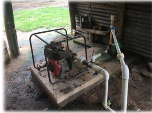
Tuberías de descargas de los pozos y aljibes
