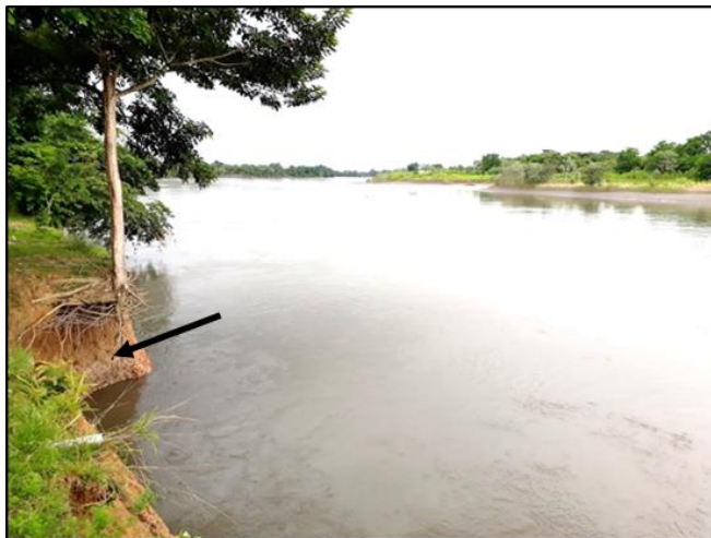
Corte de arcillas limosas en la margen izquierda del río Charte en la Vereda Santa María de Maní.
