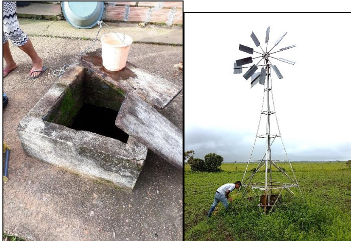
Bombeo manual (baldeo) y con molinos de vientos en los aljibes.
