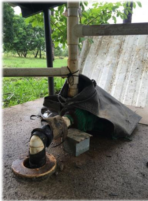
Tuberías de descargas en 4 pulg en PVC de los pozos
