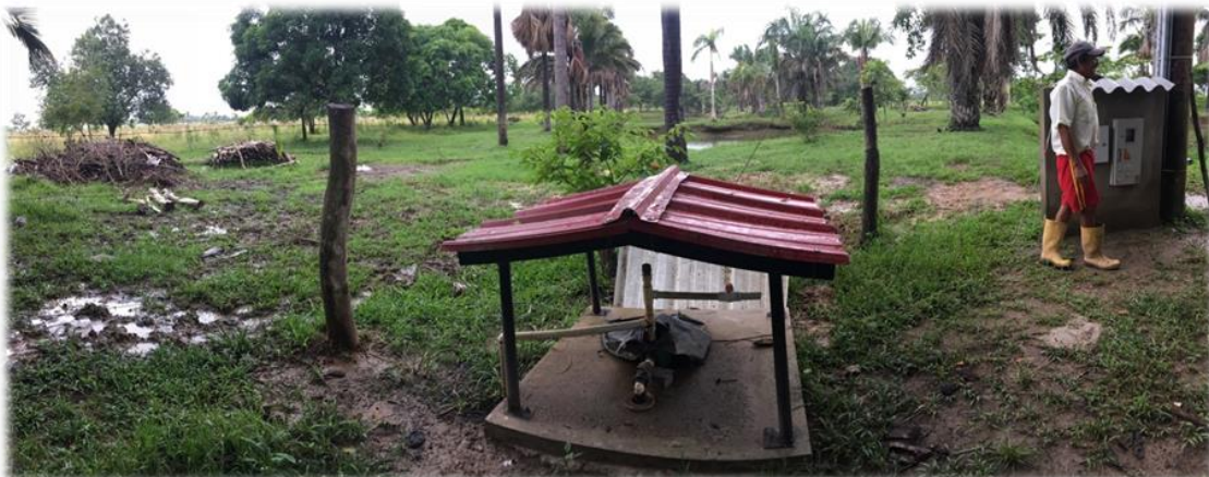
Caseta con piso de protección y tuberías de descargas en PVC en aljibes.
