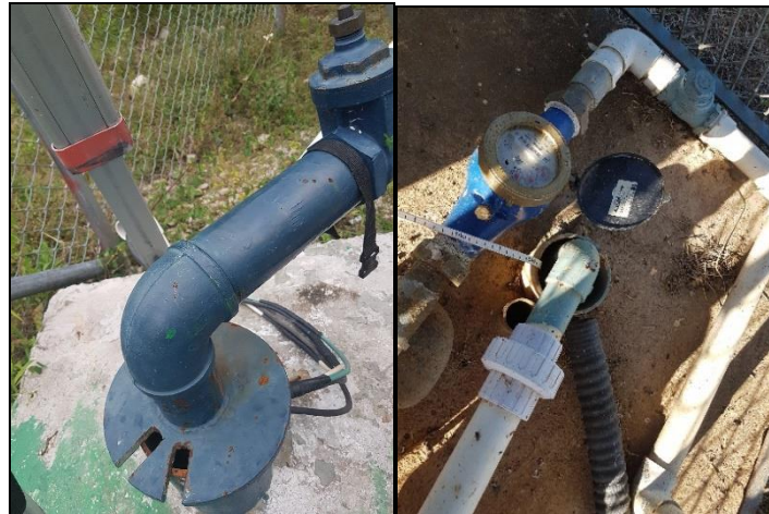
Pozos de pequeño y mediano diámetro revestido en acero y pvc.
