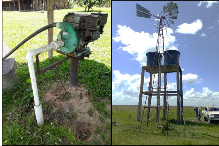
Sistema de Bombeo (Bombas centrifugas y molinos de viento)
