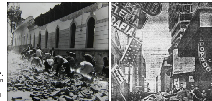
Fotografía 3: Colapso de parte de un muro en la Calle 48 con carrera 13 en Bogotá Archivo: (Instituto Geofísico de los Andes, 1967
