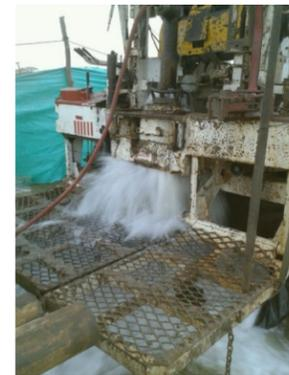
Figura 3. Ejecución de limpieza y desarrollo del pozo SGC-Manaure 2, utilizando línea de aire a presión.
