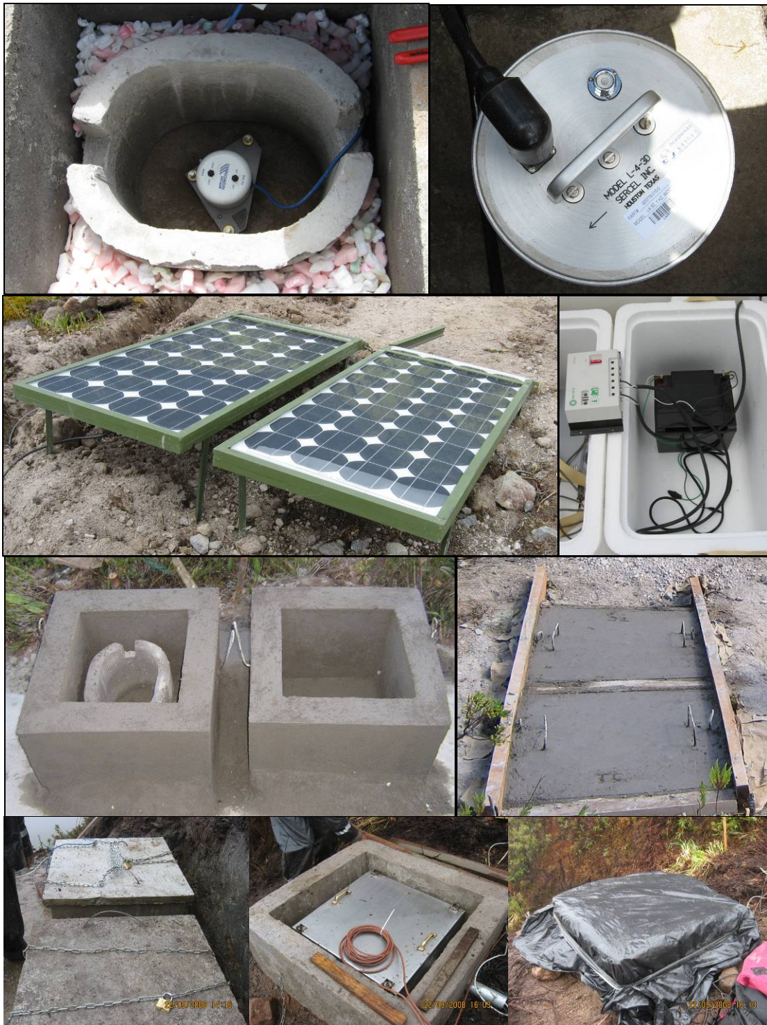
Figura 2.9. Sistemas de protección tipo para estaciones sísmológicas y de inclinometría electrónica instaladas en los volcanes Doña Juana, Cumbal y Azufral, en el departamento de Nariño. Una vez realizado el sistema de protección tanto para las estaciones como para los sitios de repetición, se procedió a realizar la instalación de los equipos.
