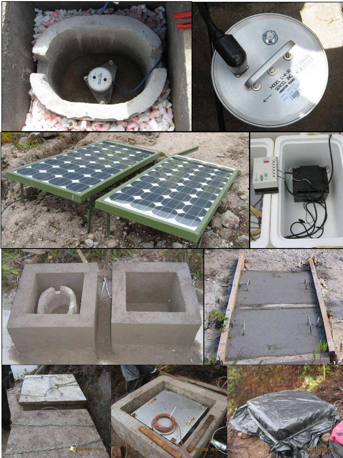
**Figura 2.9.** Sistemas de protección tipo para estaciones sismológicas y de inclinometría electrónica instaladas en los volcanes Doña Juana, Cumbal y Azufra, en el departamento de Nariño. Una vez realizado el sistema de protección tanto para las estaciones como para los sitios de repetición, se procedió a realizar la instalación de los equipos.
