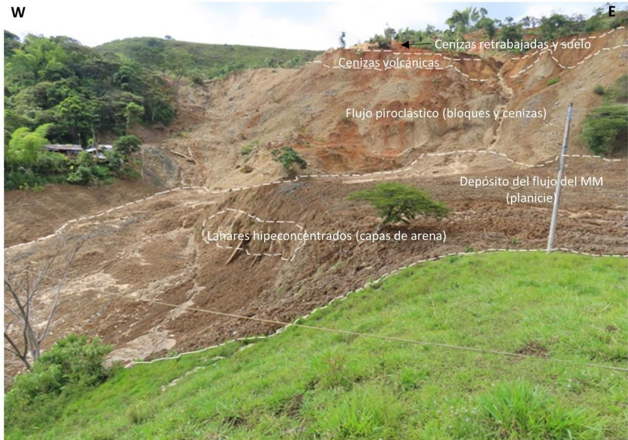
**Figura 6.** Sector del movimiento en masa, sobre el tramo destruido de la carretera Panamericana. En la figura se muestra un bosquejo de la litología del lugar, enmarcada dentro de la Formación Galeón. Toma desde el sitio de la tarabita, extremo E. Se observa el primer cambio a pendiente suave del depósito de flujo al llegar desde la parte alta.
