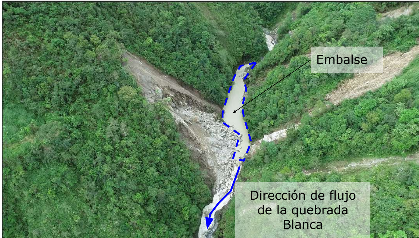
Represamiento parcial el 13 de junio de 2024, a aproximadamente 450 m del deslizamiento de 1974
