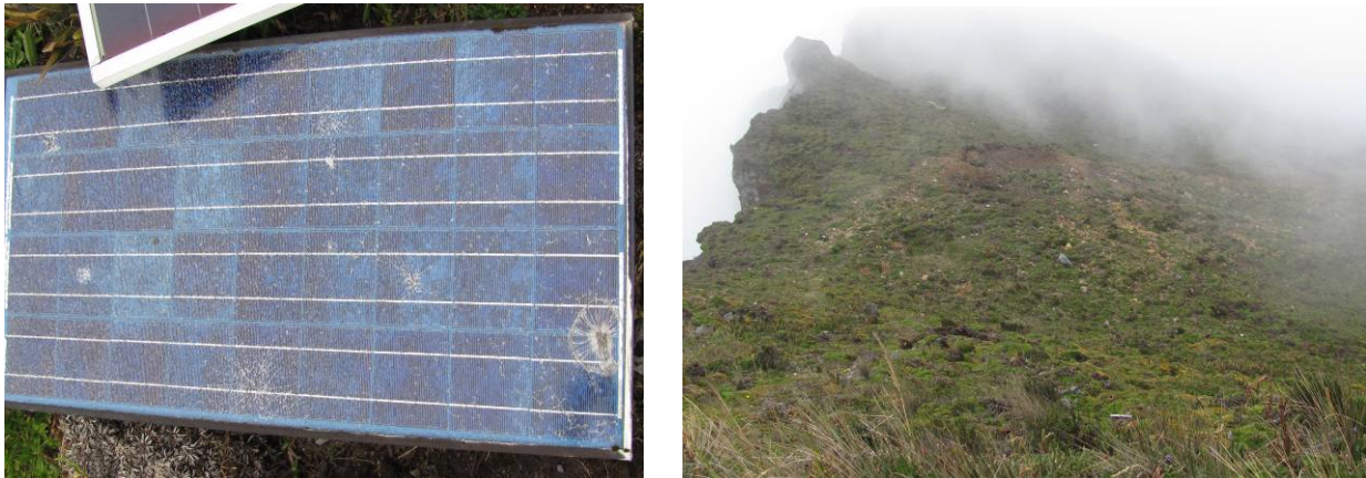
Figura 28. Estado de los paneles solares en la estación de Cráter (izquierda). Distribución de material volcánico de menor tamaño en el sector de la estación Cráter (derecha).
