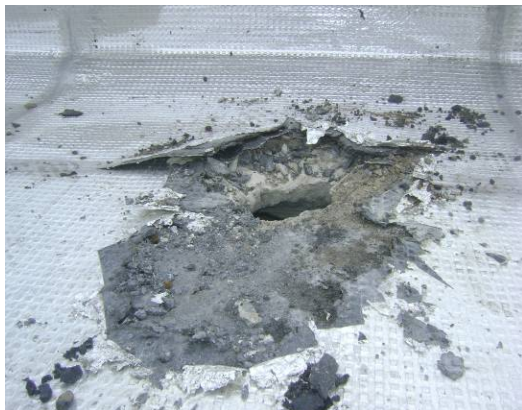
Figura 18. Efectos en el sector externo de la empresa de telecomunicaciones debido a impactos de roca.
