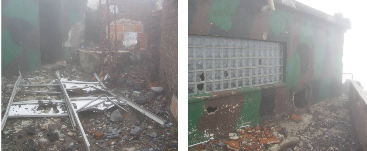
Figura 24. Efectos de los procesos eruptivos en el sector de la base militar ubicada en la cima de Galeras.
