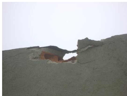
Figura 18. Efectos en el sector externo de la empresa de telecomunicaciones debido a impactos de roca.
