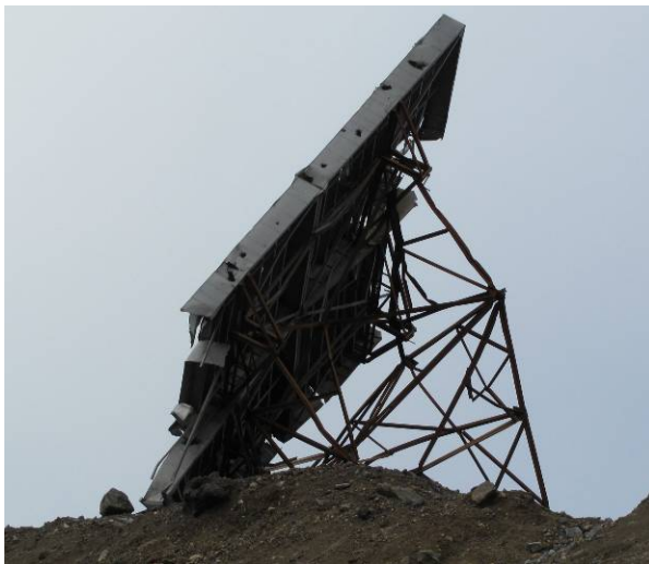
Figura 23. Imagen del reflector ubicado a pocos metros de la base militar afectado por el material emitido por el evento eruptivo del 2 de enero.
