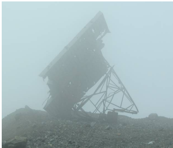
Figura 23. Imagen del reflector ubicado a pocos metros de la base militar afectado por el material emitido por el evento eruptivo del 2 de enero.
