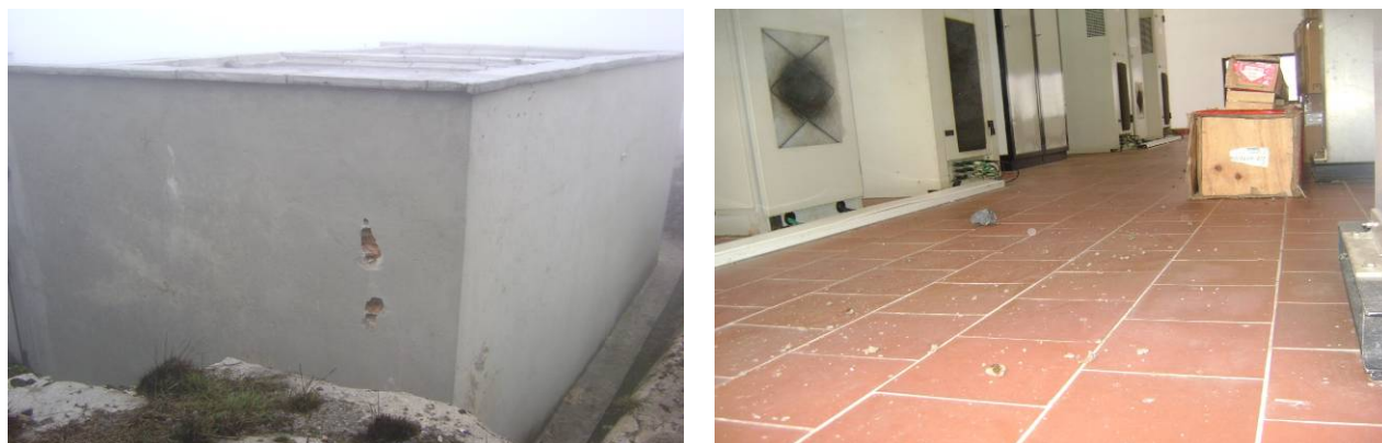
Figura 19. Efectos de los impactos de roca en la parte externa de las instalaciones, así como en la parte interna de las instalaciones de la empresa de telecomunicaciones.
