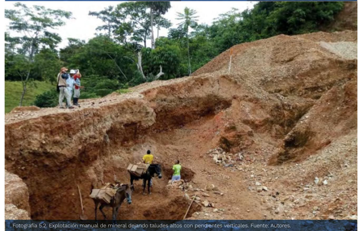
Fotografía 5.2. Explotación manual de mineral dejando taludes altos con pendientes verticales. Fuente: Autores.
