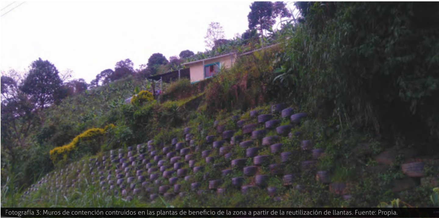
Fotografía 3: Muros de contención contruidos en las plantas de beneficio de la zona a partir de la reutilización de llantas. Fuente: Propia.
