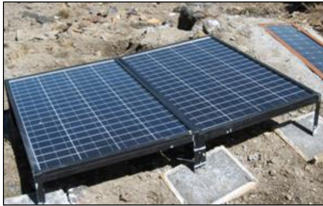
Figura 2. Mejora en sistema eléctrico de estaciones Banda Ancha.
