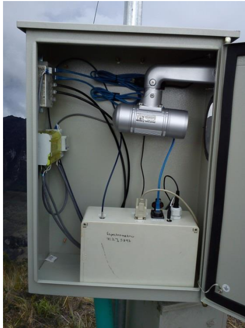
Figura 6. Cámara y ScanDOAS AZUFRADO.
