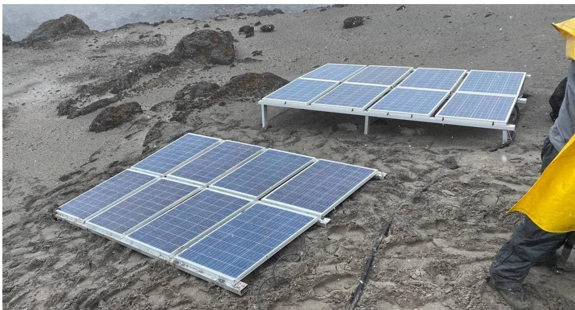
**Figura 4.** Arreglo de paneles solares en el repetidor EL CISNE
