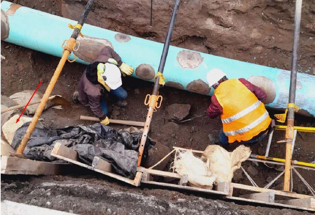
**Figura 18.** Excavación realizada en el sitio de la anomalía. Nótese las rocas sueltas en el fondo del apique. La flecha roja indica un punto donde se observó salida de gases, con una temperatura de 54.1 °C medida el 27 de mayo
