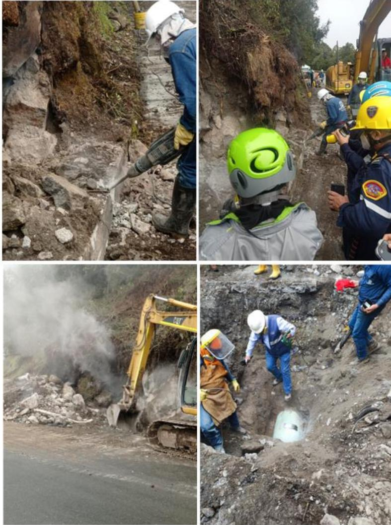
**Figura 28.** Trabajos de excavación por parte de la empresa TGI. Se aprecia la persistencia de salida de gases
