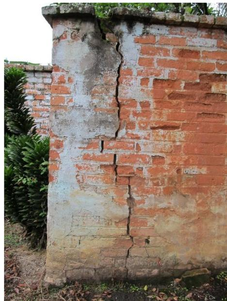
**Figura 19.** Grieta en muro de cerramiento (Alpujarra, Tolima).
