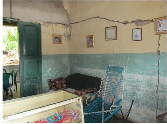
**Figura 21.** Reapertura y ampliación de grietas en conexiones de muros (Baraya, Huila).
