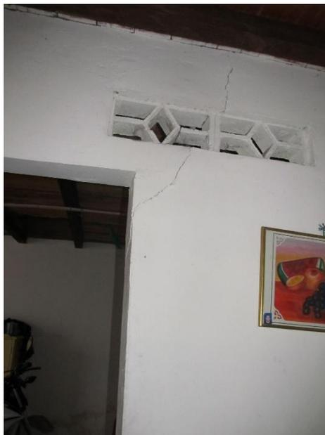
**Figura 18.** Ampliación de grieta preexistente en muro (Tello, Huila).
