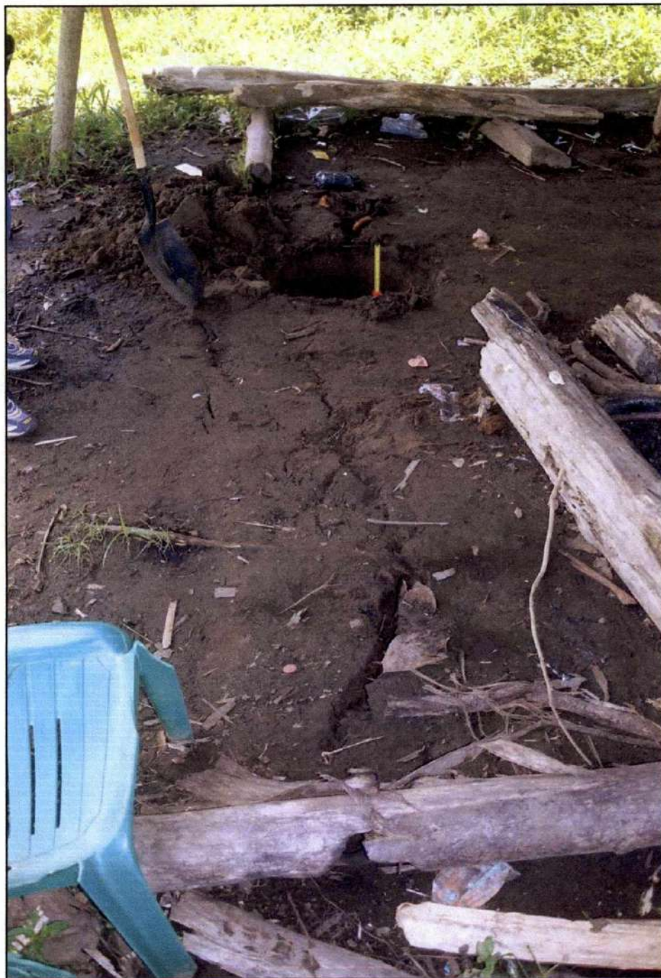
Fotografía 2.3. Agrietamientos laterales paralelos a la línea de costa en Pizarro.
