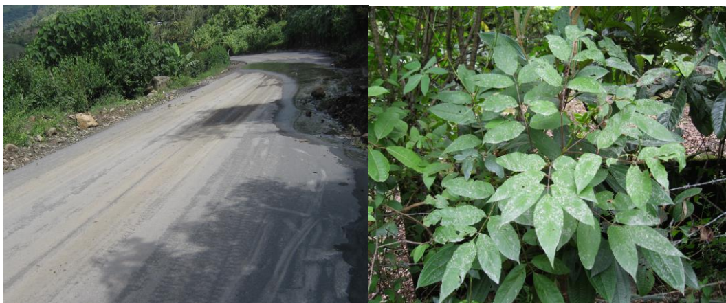
Figura 2.15. Fotografías de las cenizas de caída depositadas sobre la vía circunvalar en el sector de Bomboná (Consacá) al occidente del volcán.
