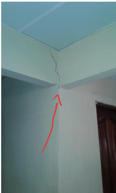
Grietas y separación de muros.
