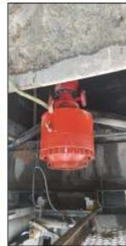
Instalación del sistema preventivo de explosiones (válvula BOP)
