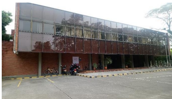
Fotografía N°23. Fachada sede Cali.
