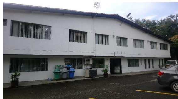
Fotografía N°35. Fachada sede Medellín.
