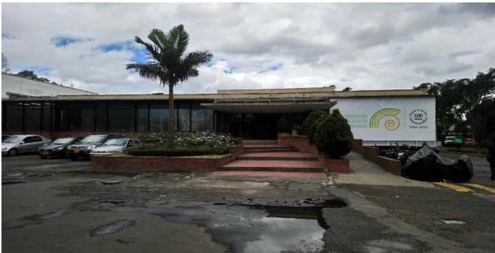
Fotografía N°1. Fachada Sede Central.
