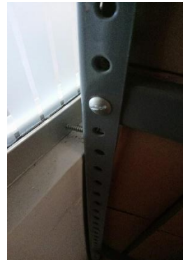
Fotografía N°57. Tornillo de anclaje al muro
