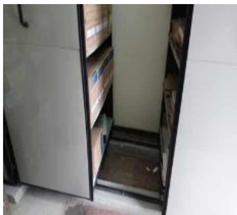
Fotografía N°6. Suciedad en el suelo. Nómina.
