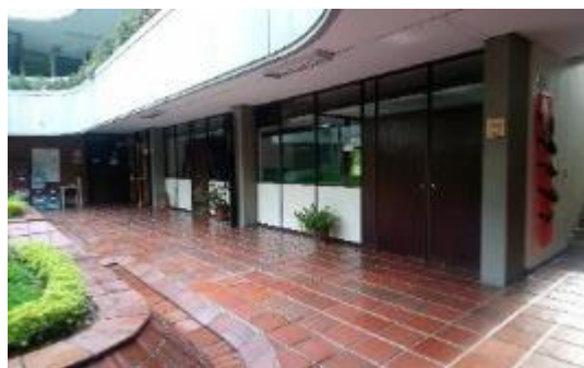
Fotografía N°32. Área de exterior de la biblioteca.
