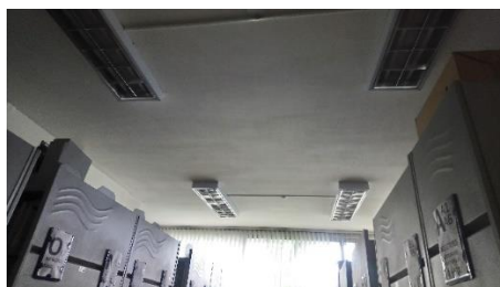
Fotografía N°71. Iluminación mixta en la biblioteca.
