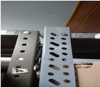
Fotografía N°56. Sistema de anclaje entre estantes con tornillos.
